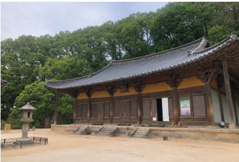
부석사 무량수전, 경상북도 영주 Muryangsujeon in Buseoksa Temple, Yeongju, Gyeongsangbuk-do
